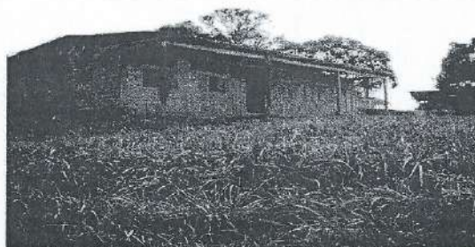
Ecole maternelle de Bikok-centre non achevée et mal équipée mais opérationnelle.
